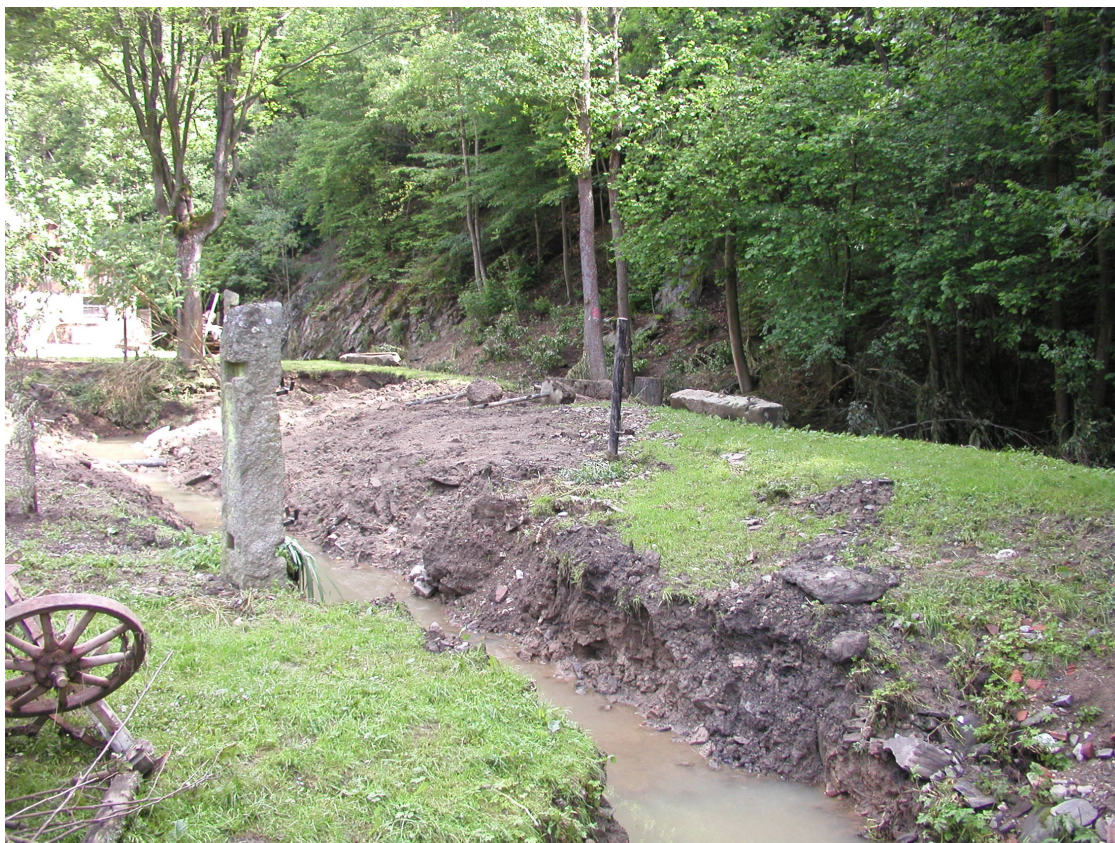
Obr. 7 – Odpadní koryto od nádrží pstruhové sádky (pohled proti vodě)
