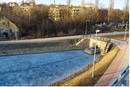
Ochranný polder (nádrž) na Brusnici v Praze na Petynce.
