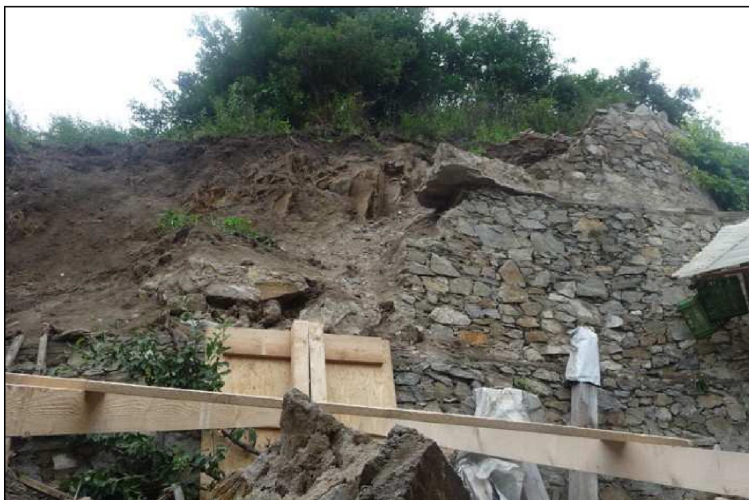
Foto 37: Provizorní zabezpečení opěrné zdi
