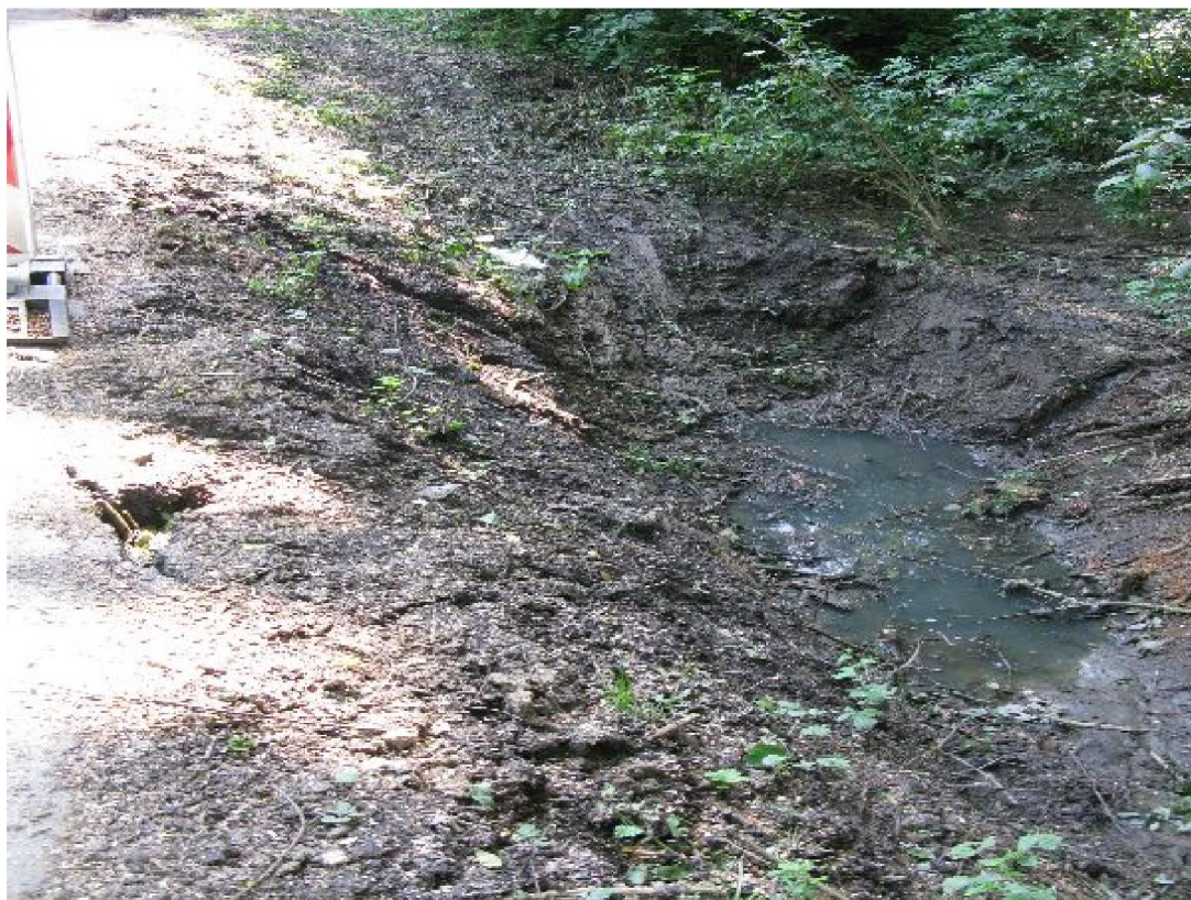
Foto 8: detail trativodu komunikace III/10564
