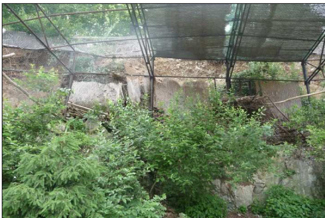
Foto 35: Prostor v zadní části voliéry, kde drátěné pletivo zadrželo sesutý materiál
