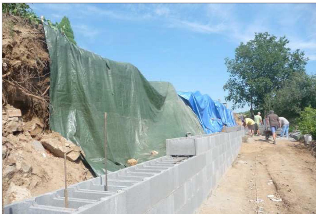
Foto 32: Nově budovaná opěrná zeď
