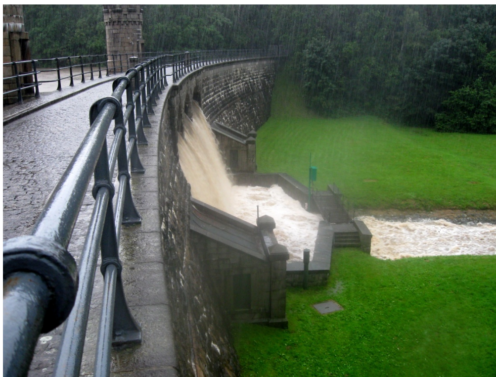
Obr. 2.12 - VD Fojtka, bezpečnostní přeliv v činnosti (7.8. 9:46 hodin)
