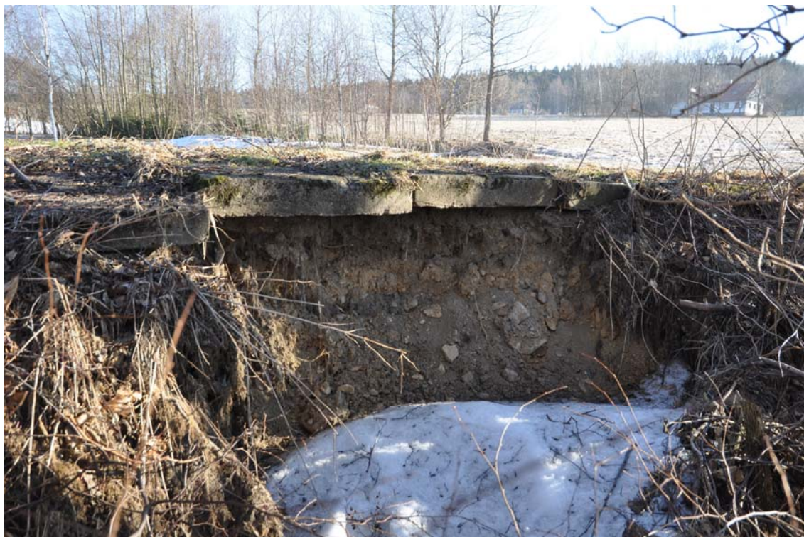
Obr. 3.40 – Retenční nádrž Albrectice – pohled na porušený vzdušný svah v profilu nad spodní výpustí
