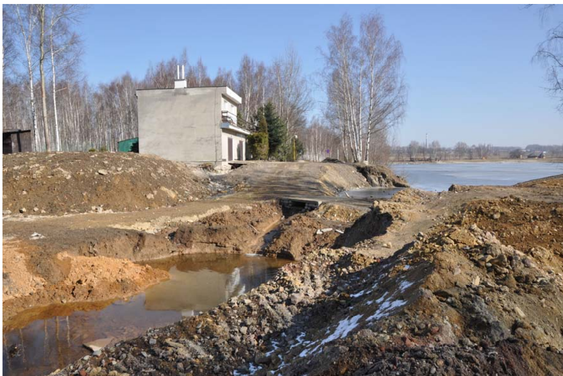
Obr. 3.42 – Kristina – protržená ochranná hráz v severozápadní části – pohled na průřvu od návodní paty tělesa hráže
