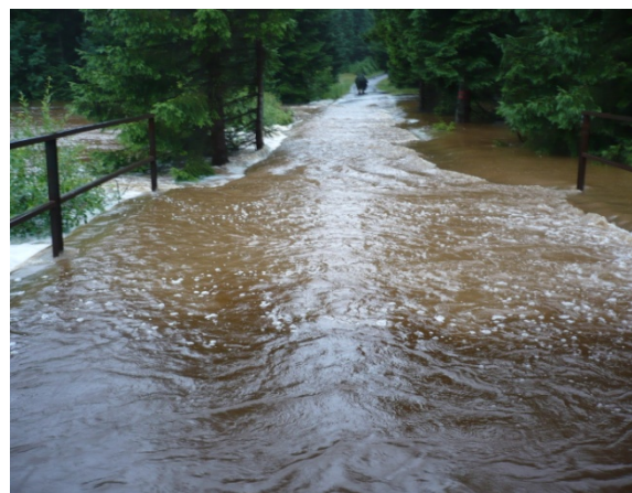
Obr. 2.4 - Blatný potok 7.8.2010, přelévání mostku na Novou Louku
