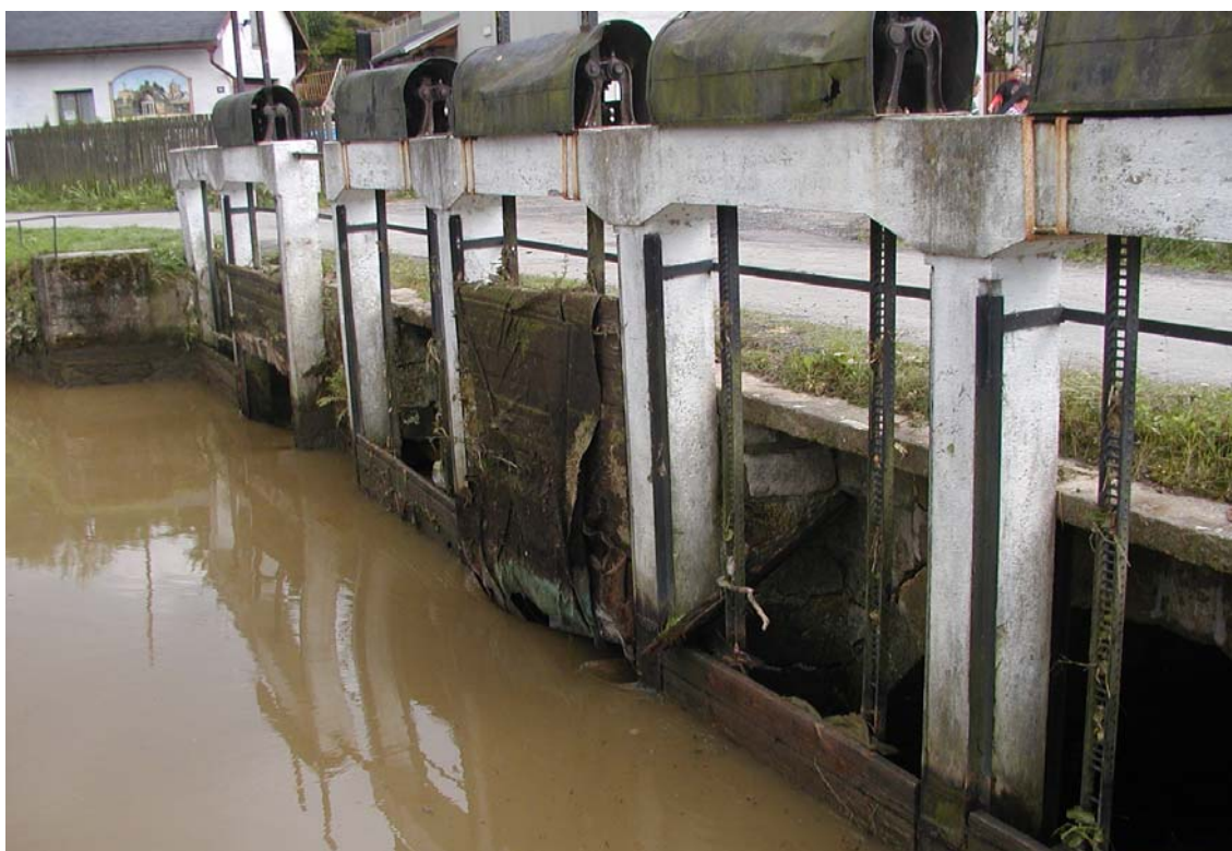
Obr. 3.22 – Markvartický rybník – Stavidla bezpečnostního přelivu.
