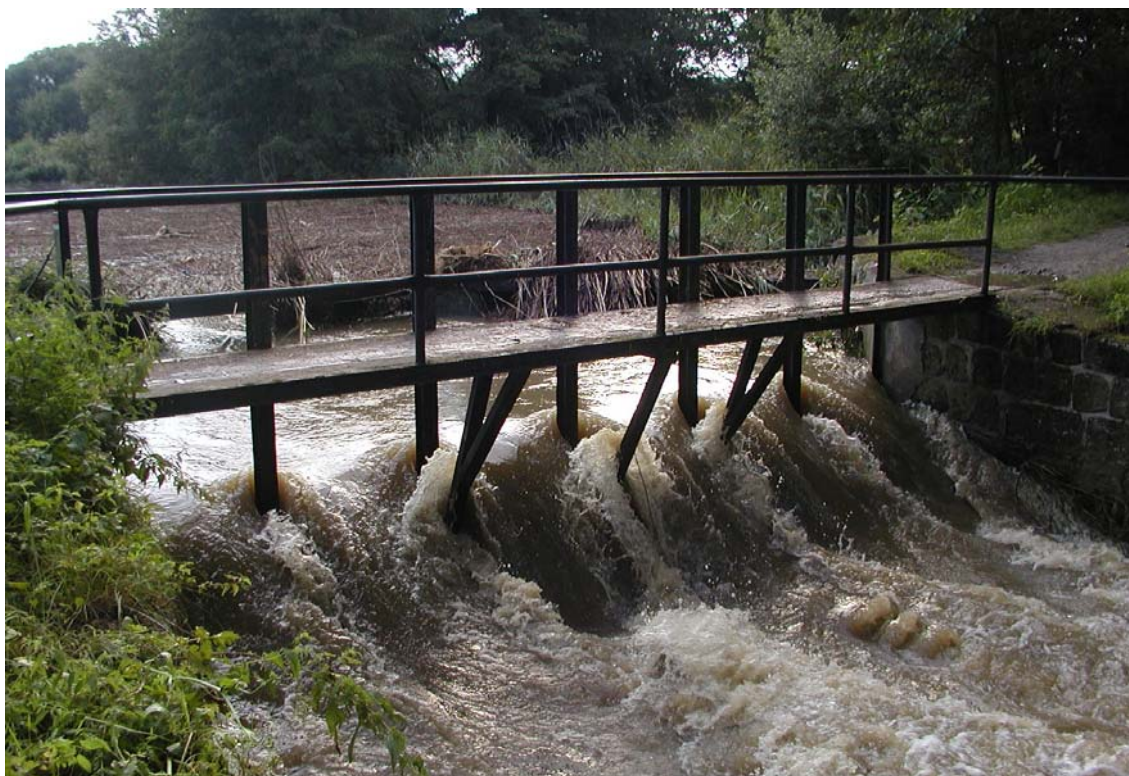
Obr. 3.15 – Holanský rybník – levý bezpečnostní přeliv
