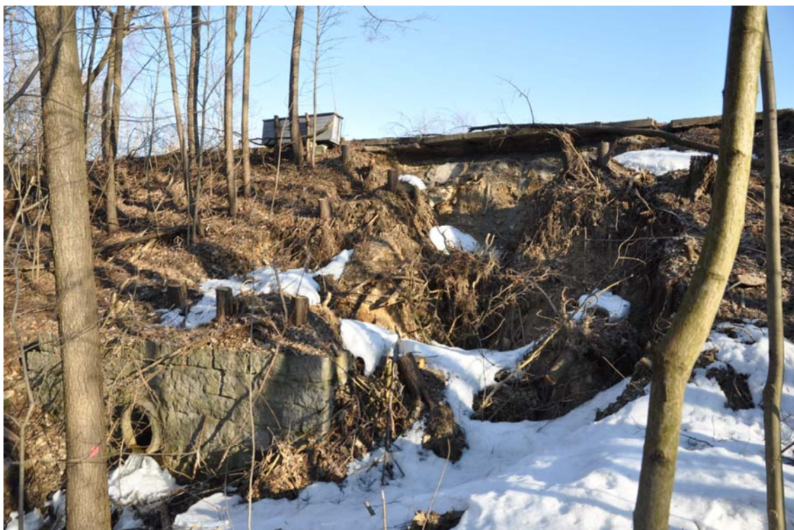
Obr. 3.40 – Retenční nádrž Albrectice – pohled na porušený vzdušný svah v profilu nad spodní výpustí
