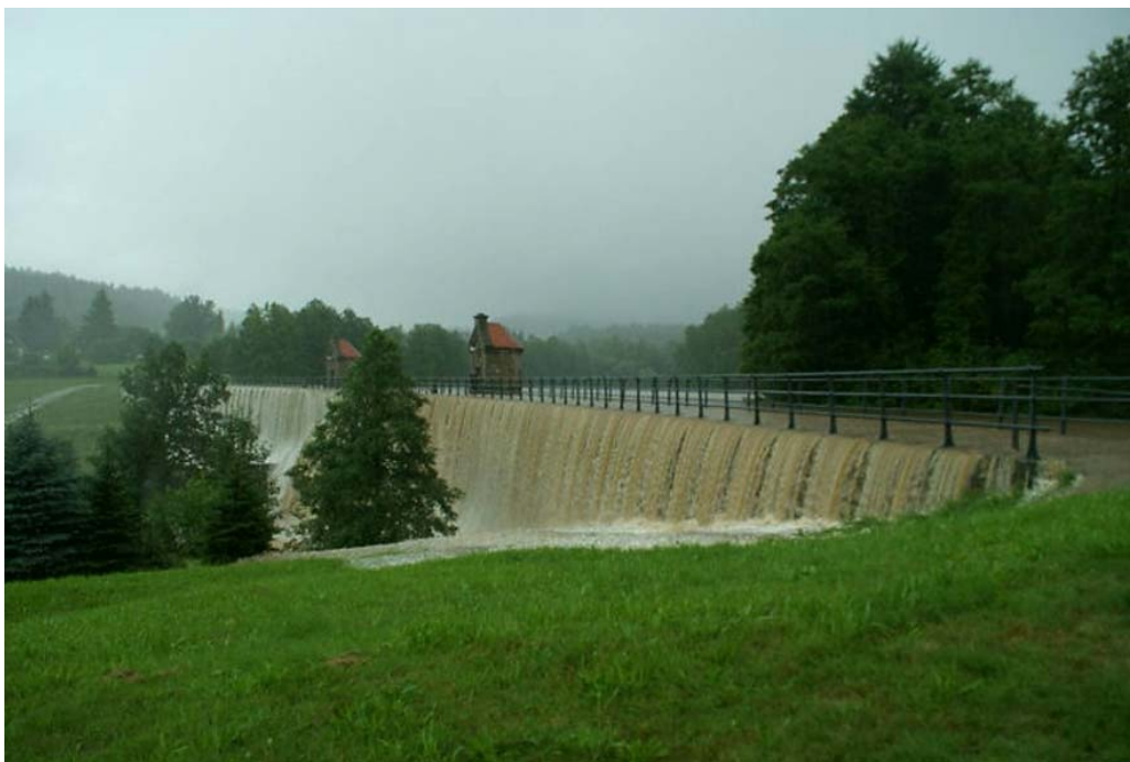
Obr. 2.14 - VD Mlýnice, přelévání koruny hráze (7.8. 10:56 hodin)
