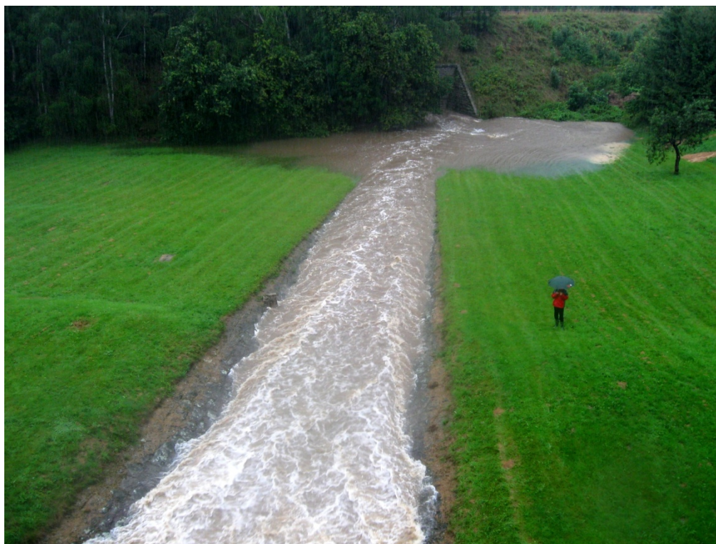
Obr. 2.13 - VD Fojtka, odpadní koryto při povodni (7.8. 9:46 hodin)
