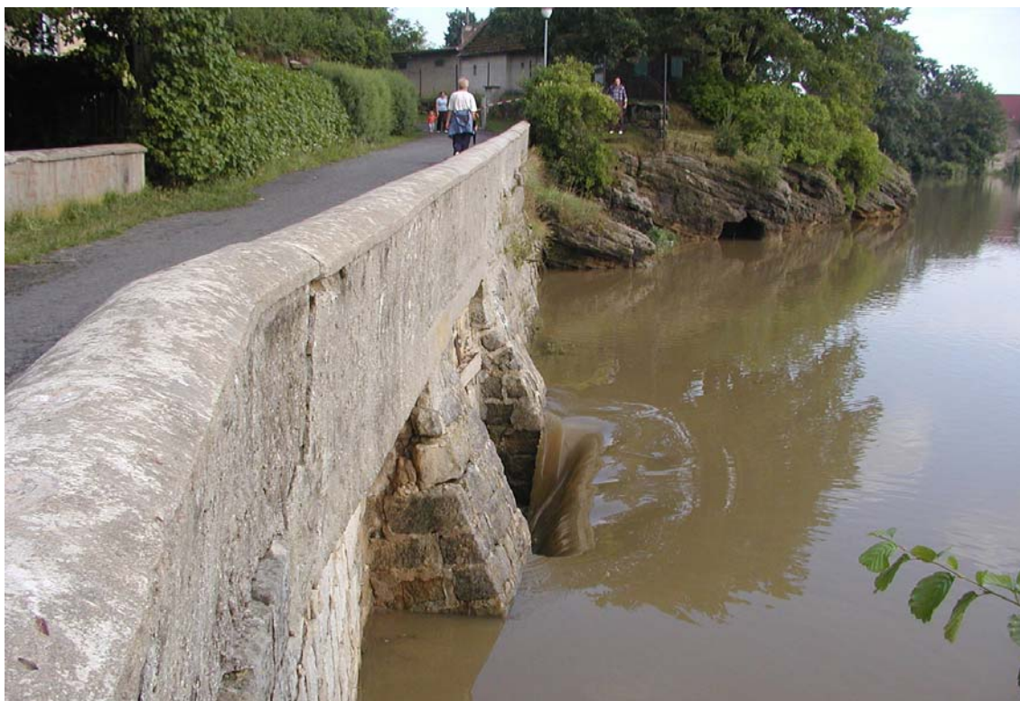
Obr. 3.13 – Holanský rybník – Sdružený objekt v pravém konci hráze
