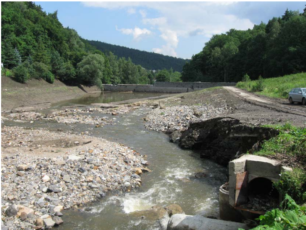
Obr. 4.2 – Prostor nátoku do obtokového potrubí v červenci 2010
