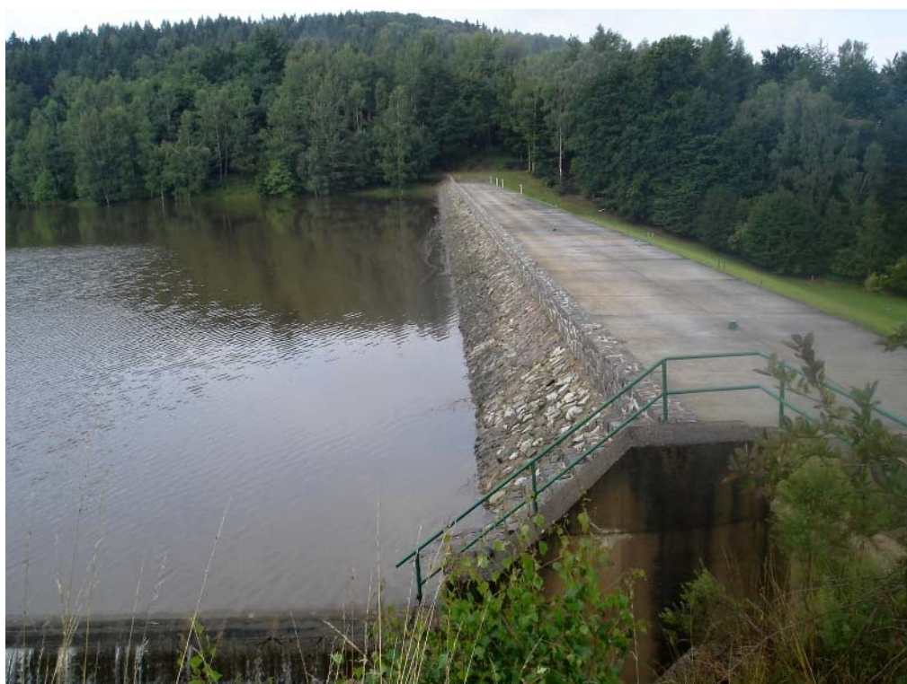
Obr. 2.11 - VD Chřibská, těleso hráze, nádrž dne 8.8.2010
