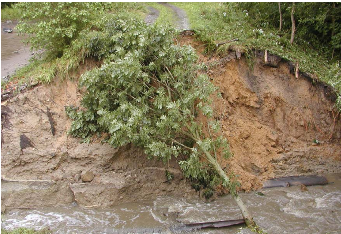
Obr. 3.18 – Kněžický rybník – Pohled z koruny hráze na průrvu v profilu spodní výpusti.
