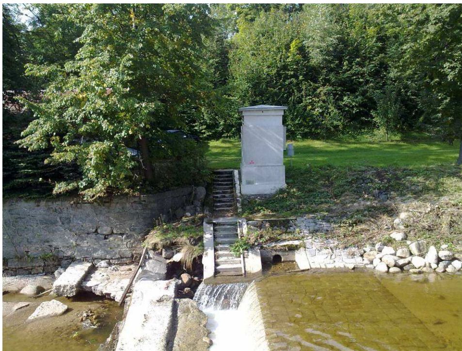
Foto 8.1 Objekt limnigrafické stanice Bílý potok se značkou maximální hladiny a poškozeným stabilizačním prahem
