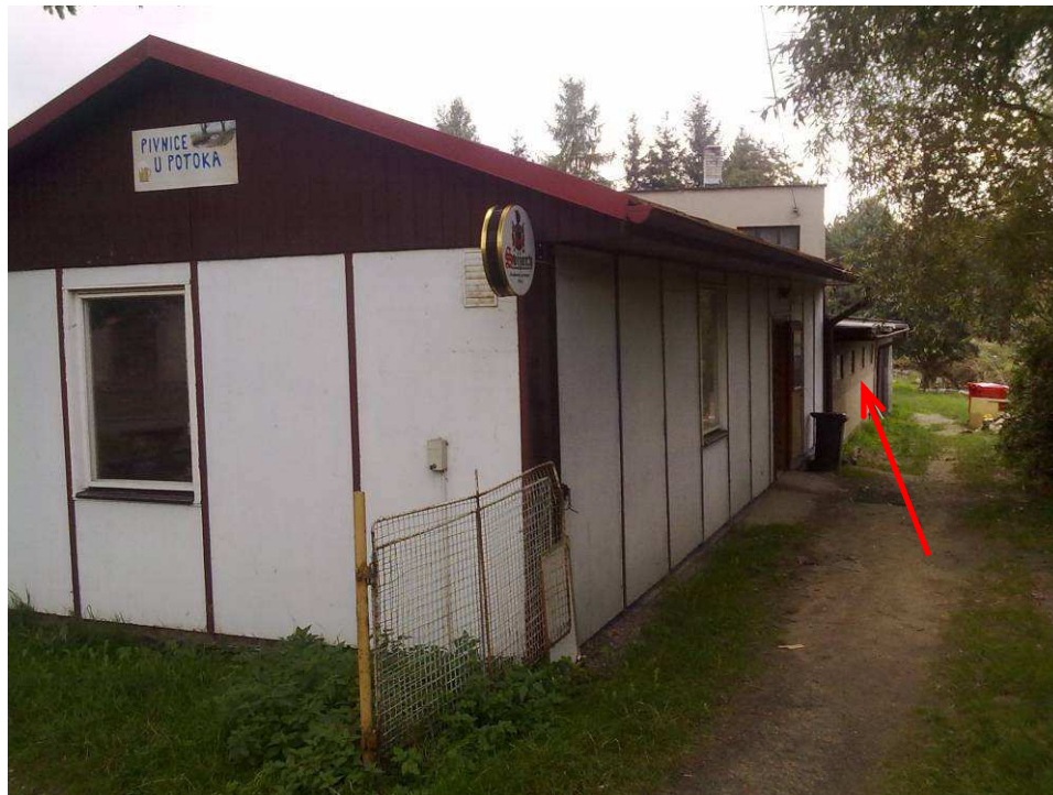
Foto 10.1 Stopa na objektu hospody pod silničním mostem
