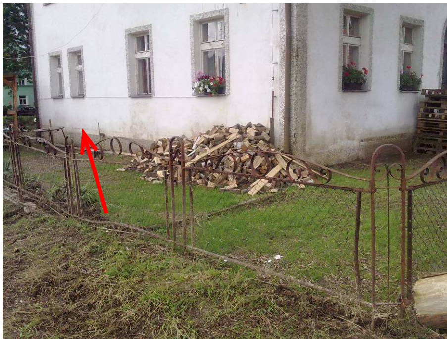
Foto 11.4 – Stopa po kulminační hladině na jednom z domů v blízkosti silničního mostu ve Višňové
