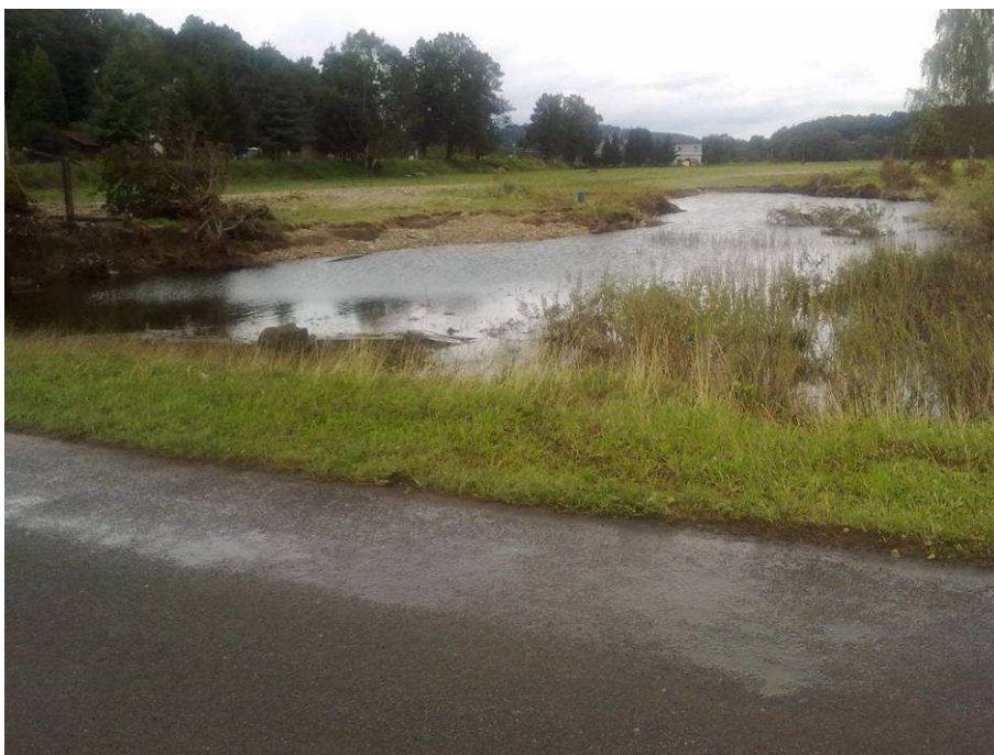
Foto 11.2 – Vymletá plocha pod místní silnicí v místě největších rychlostí vody v zaplaveném území podél obce Višňová
