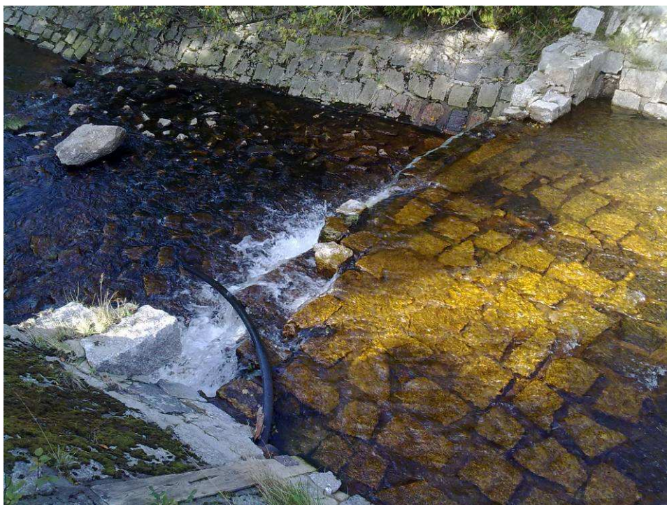
Foto 7.3 Zničená přelivná hrana stupně v profilu limnigrafické stanice na Smědě ve Smědavě
