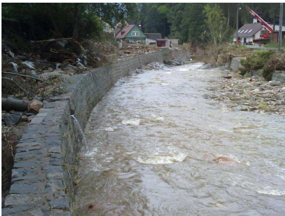
Foto 4.2 Nepoškozené opevnění úpravy Jeřice ve střední části měrné tratě
