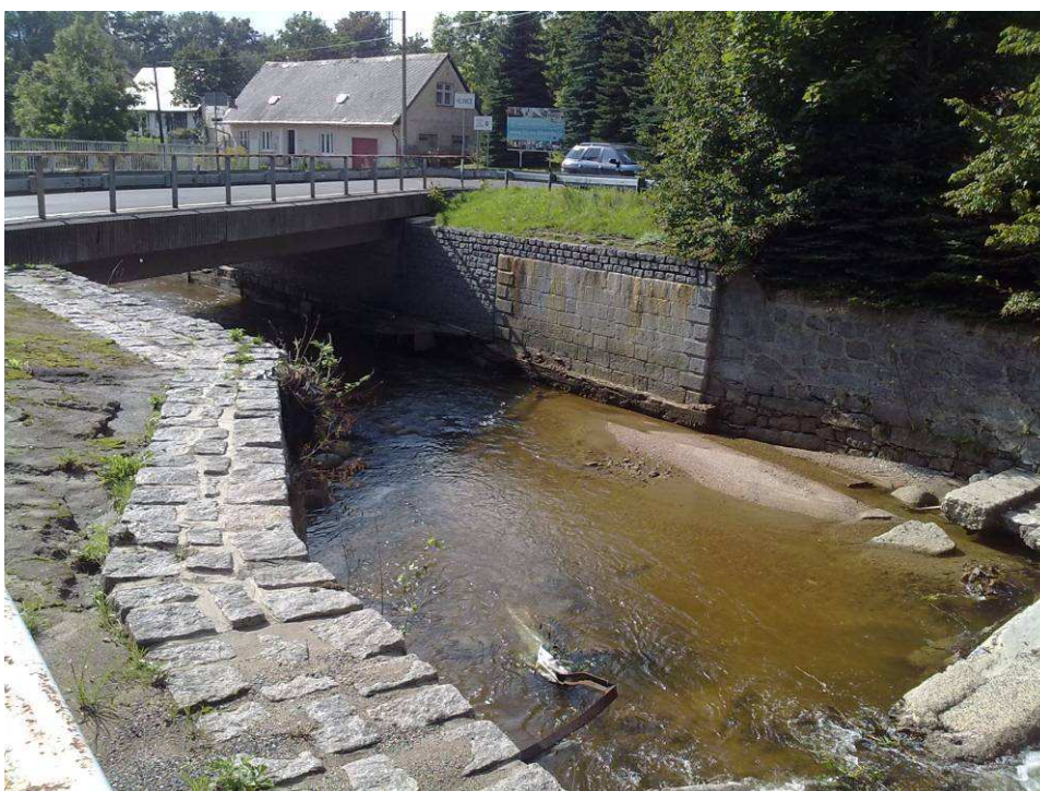
Foto 8.2 Vymleté dno Smědé nad profilem silničního mostu v Bílém potoce
