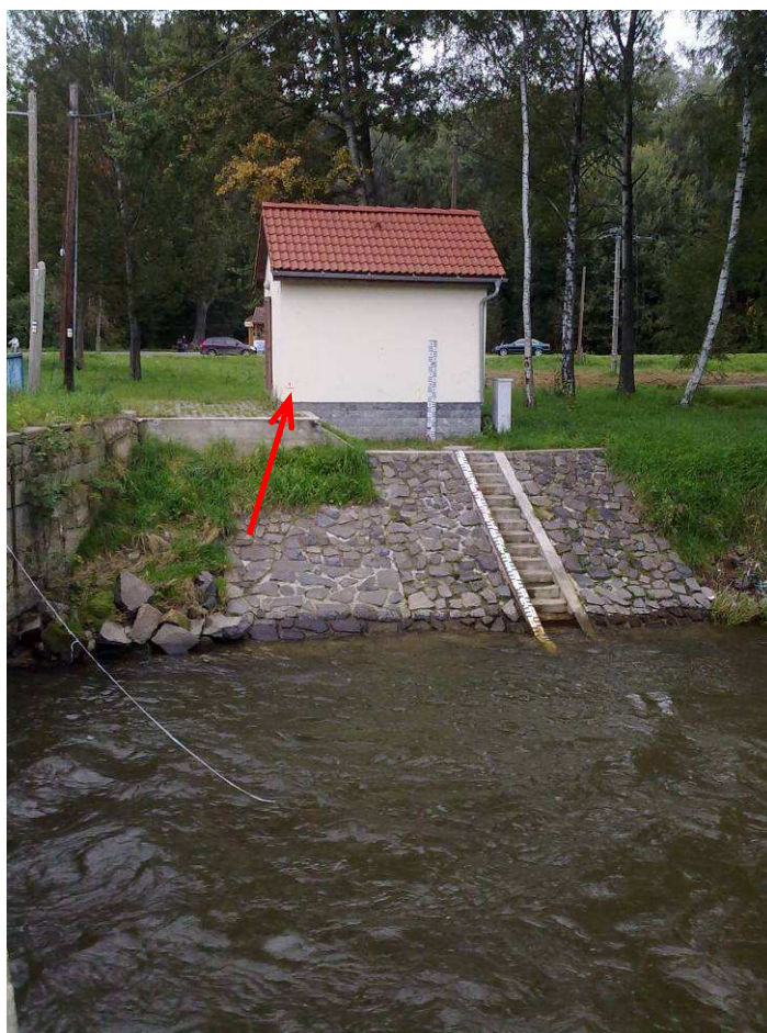
Foto 5.2 Objekt limnigrafické stanice Hrádek se značkou po kulminační hladině
