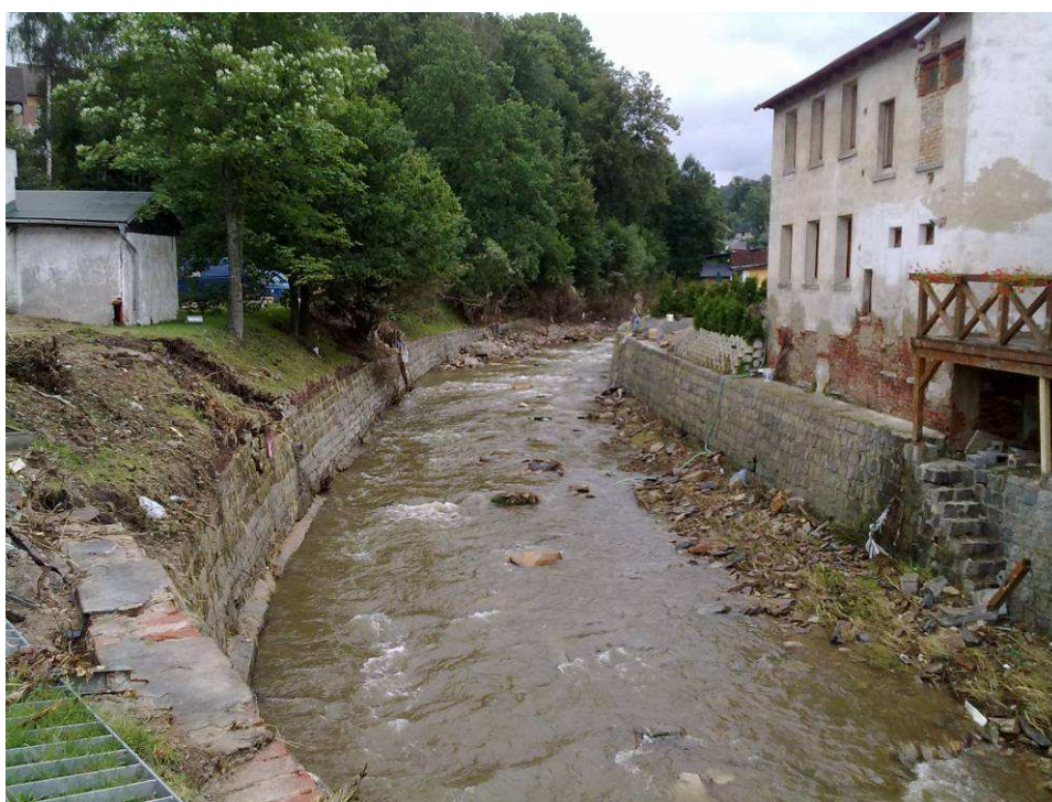
Foto 4.5 Jeřice v Chrastavě nad klenbovým mostem
