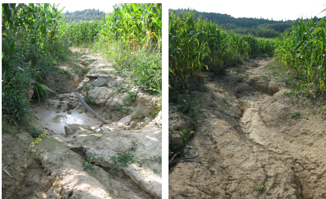
Obr. 7.1 Výrazné projevy eroze v dráze soustředěného odtoku
