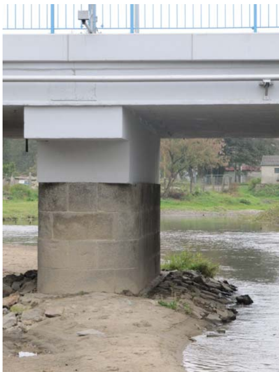
Obr. 7.5 – Příklady nevhodného umístění hladinového čidla
